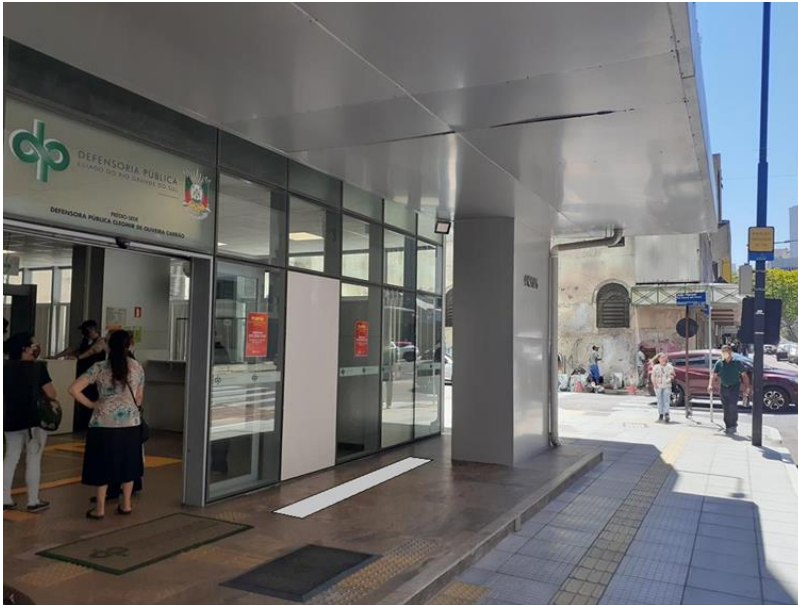
Local para a instalação da base das bandeiras
